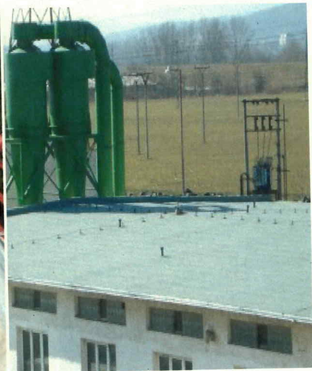
Oprava strechy Beluša
